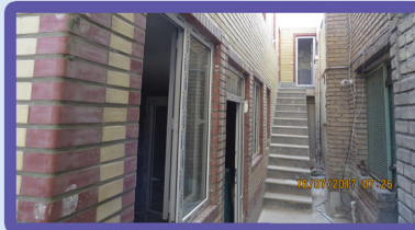
احداث اتاق اساتید پردیس امیر کبیر
