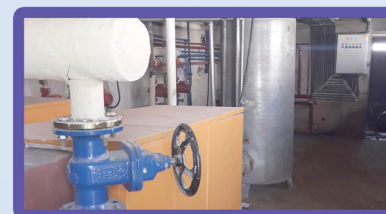
تعمیر، نوسازی و راه اندازی سیستم گرمایشی پردیس های استانی از محل اعتبارات سازمان نوسازی مدارس
