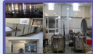
بهسازی و ترمیم آشپزخانه پردیس علامه طباطبایی
